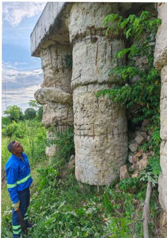
Fotografía 2. Perfil de columna de Caisson costado de la planta de El Prado. Acuecar SA ESP
