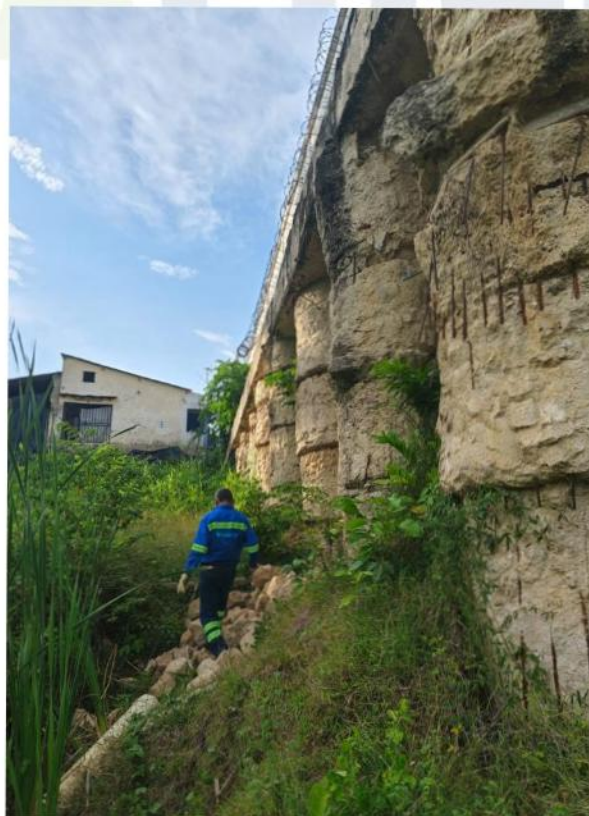
Fotografía 3. Vista del avance de desconfiamento de los Caisson sobreel tanque No. 3
